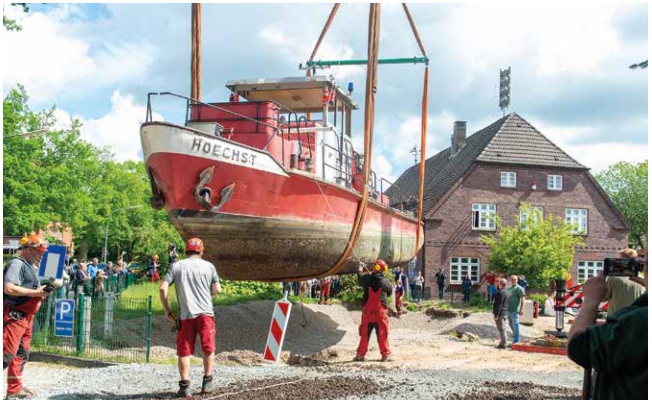
Absenken des Feuerlöschbootes HOECHST in eine mit Kies gefüllte Baugrube
