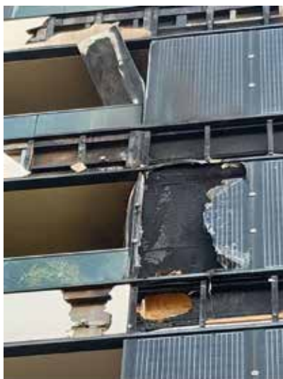
Brand einer in die Fassade integrierten PV-Anlage Foto: Feuerwehr Frankfurt
