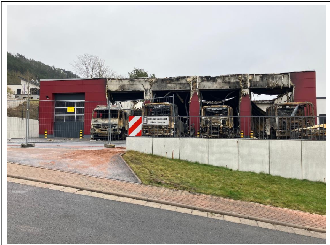
Feuerwehr Treffurt, Brandschaden 2025
